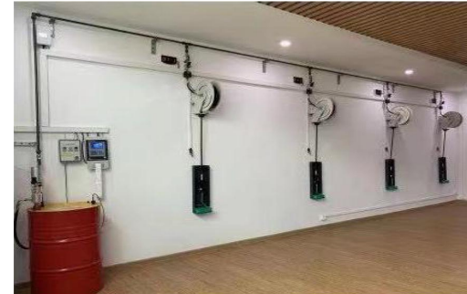
Diagrama esquemático do sistema de abastecimento de óleo centralizado
